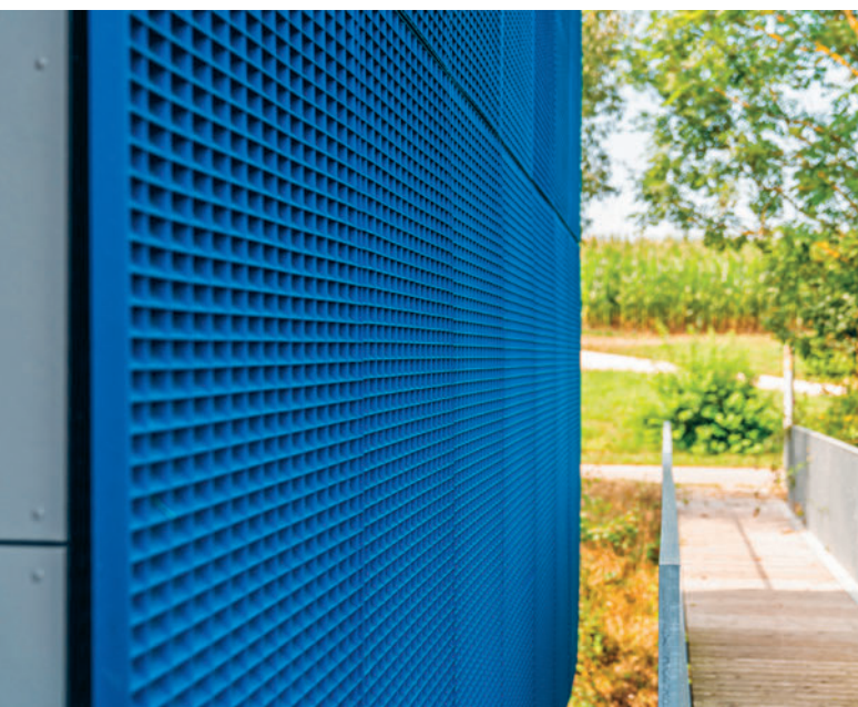
Die horizontale Fluchtung der einzelnen Lamellen erwies sich als spannende Herausforderung.
